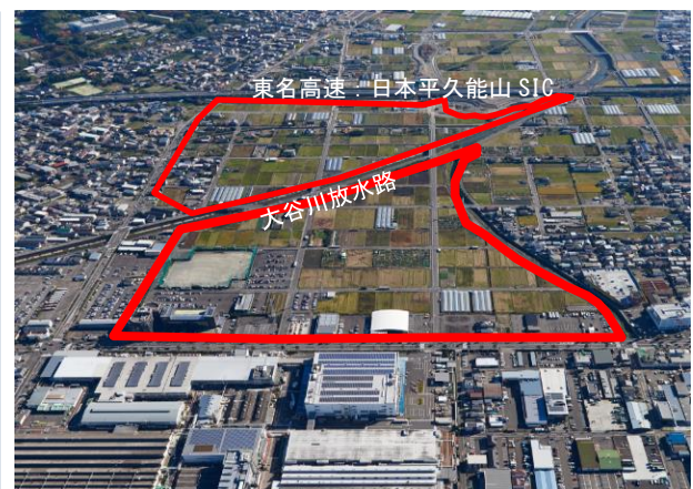
図-2 航空写真（着工前）
