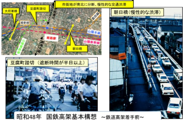
事業前の姫路駅周辺道路の状況
