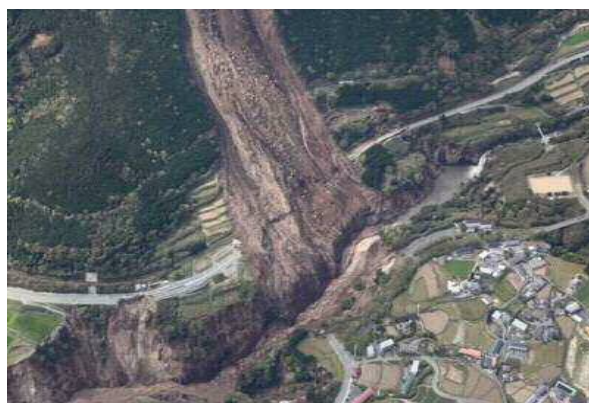
写真—阿蘇大橋付近の被害状況(南阿蘇村)
