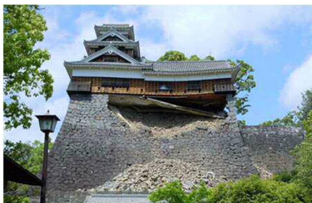
写真—熊本城の被害状況(熊本市)
