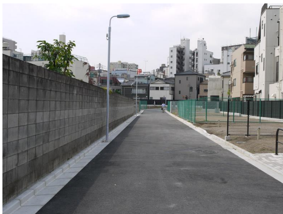
完成した5メートル道路、無電中化されている
